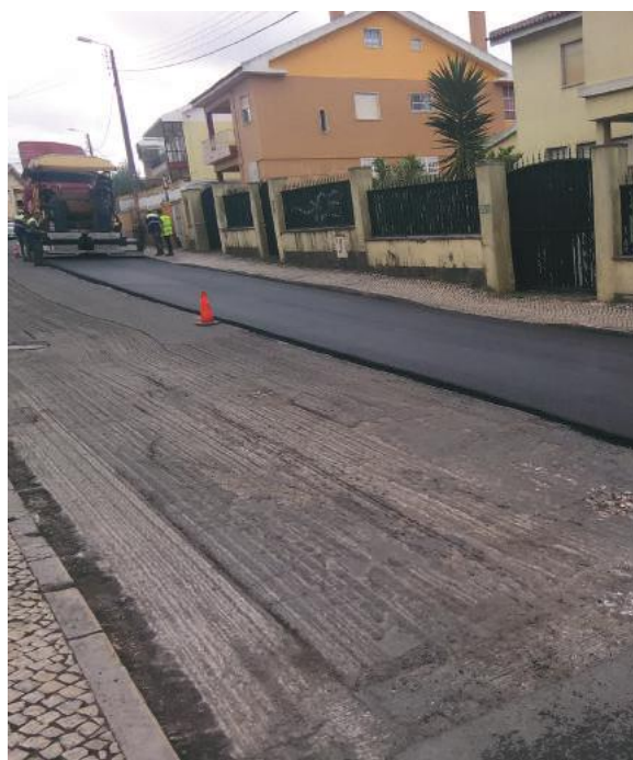
Reabilitação do pavimento rodoviário na Av. da Bela Vista em Mem Martins
